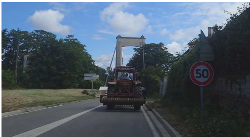
RD 14 à l'entrée du pont de Belleperche (source : photo SOE)
