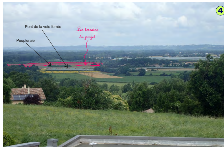
Vue depuis le point de vue de Cordes-Tolosannes
